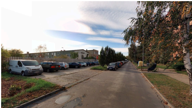
Jednořadé parkoviště na východním okraji Hutníku dnes - auta stojí i podél silnice.
